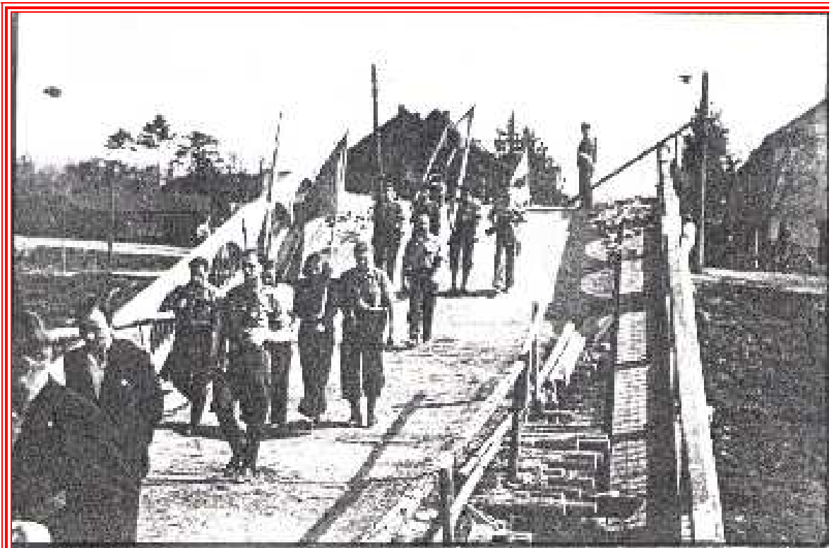
Květen 1945 Zničený most přes Mošťenku v Horní Mošťenici. Most zničili Němci poté, co museli partyzáni ustoupit před značnou přesilou Němců. Při bojích u mostu byl těžce raněn i dobřčický partyzán Jan Masařek, který následkem těžkých zranění zemřel
