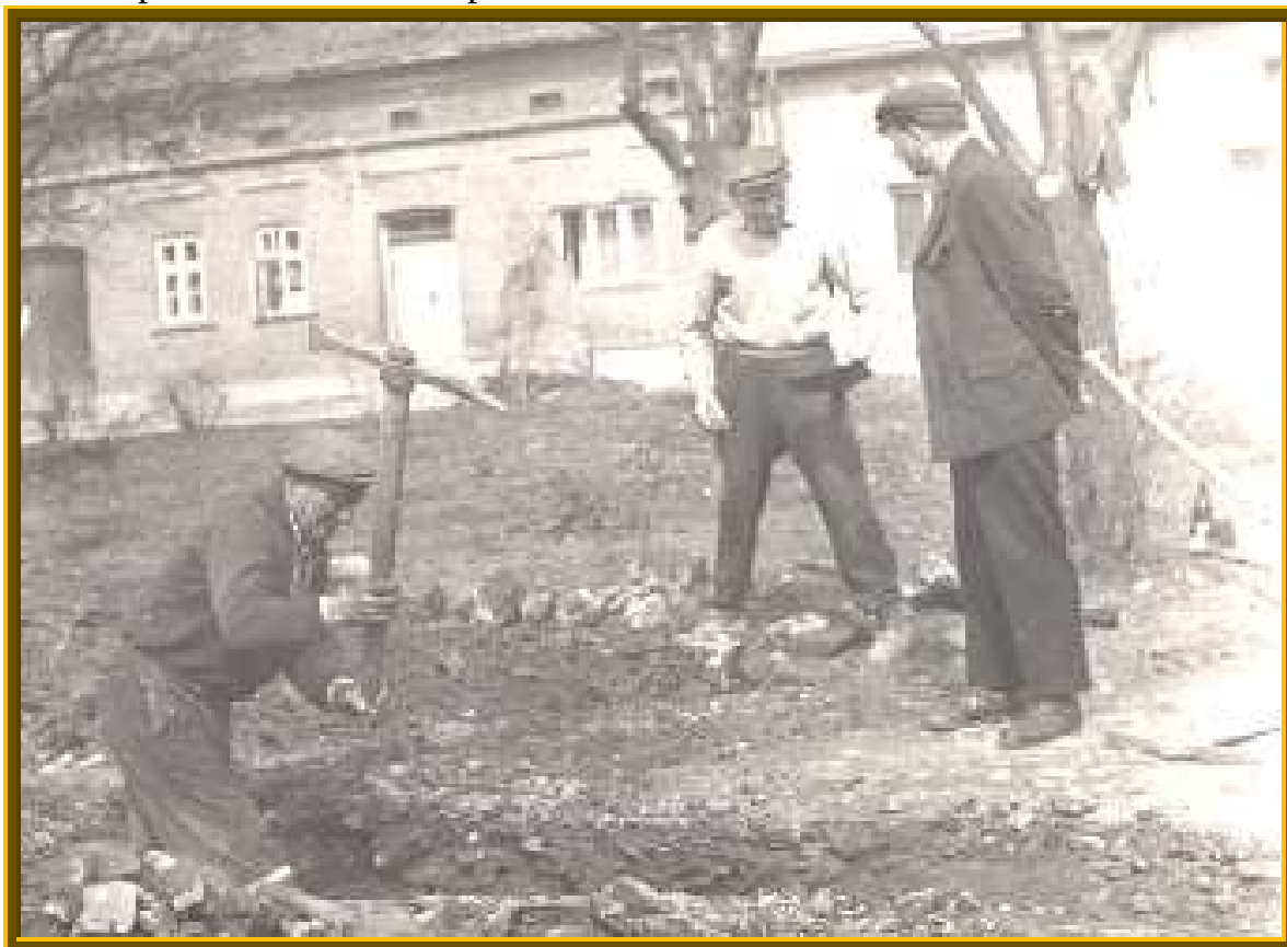
Brigáda na budování kanalizace v obci počátkem 60. let minulého století. Kopající Josef Motáš, uprostřed Augustin Ostrčil a vpravo Vilém Jurčík. V pozadí je dům Jurčikových na točně.
