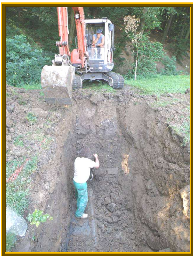
Práce na opravě hráze rybníka a pohled na nově osazené potrubí výpustky.
