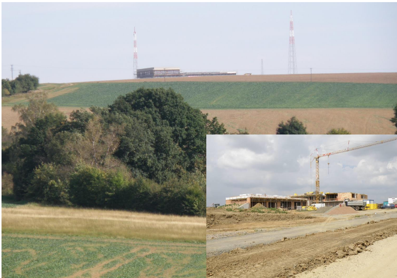
Rozestavěná budova a pohled na stavbu z horní části beňovské cesty při pohledu směrem na Zaziny
