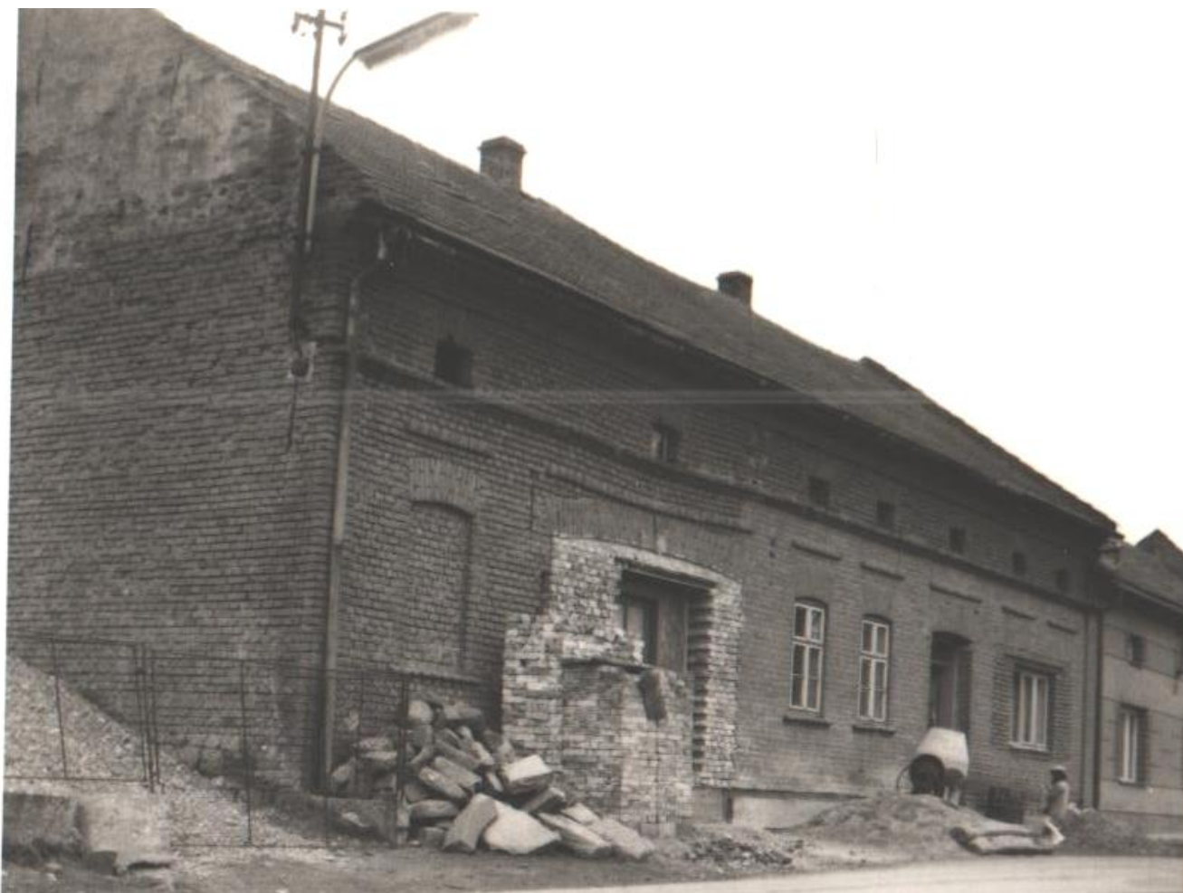
Dům č. 15 v rekonstrukci v roce 1970. Uprostřed 2 původní okna a dveře. Krajní okna nová
