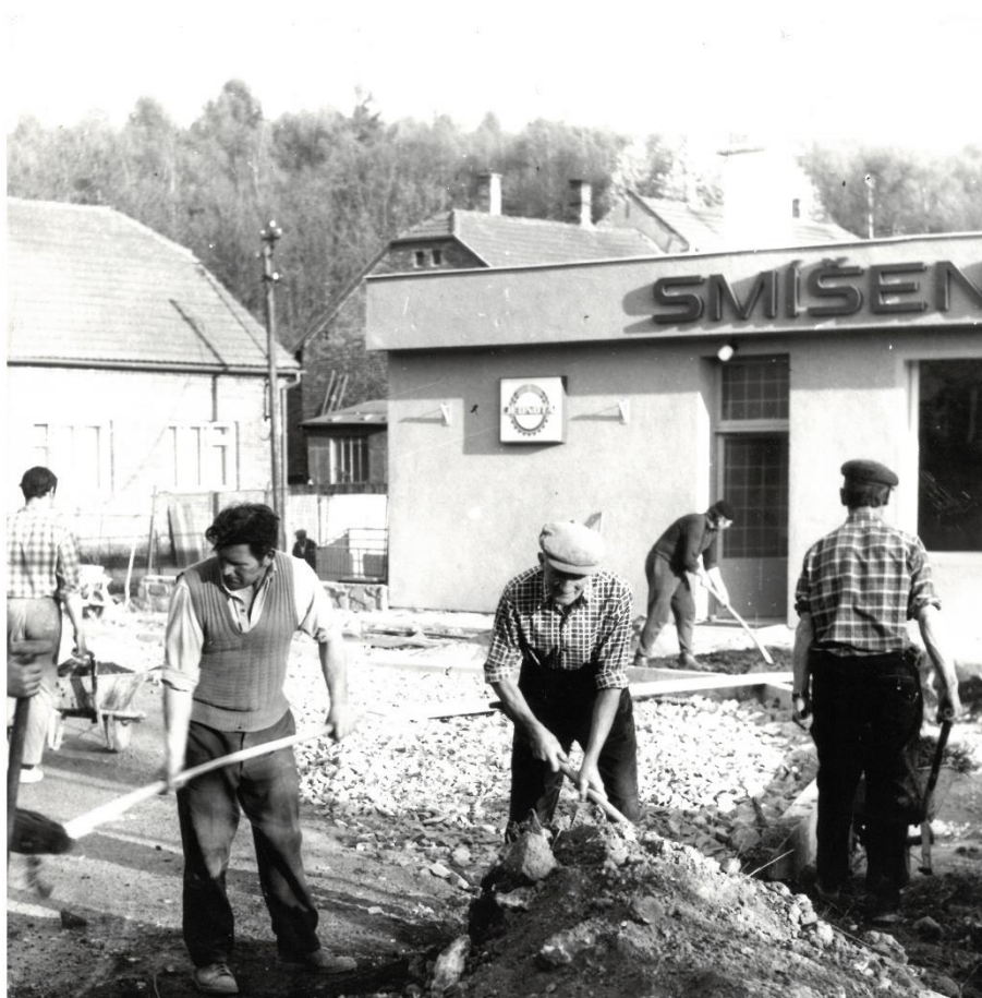
Stavba obchodu na točně, úprava prostranství před prodejnou, 1973-74 zleva:
