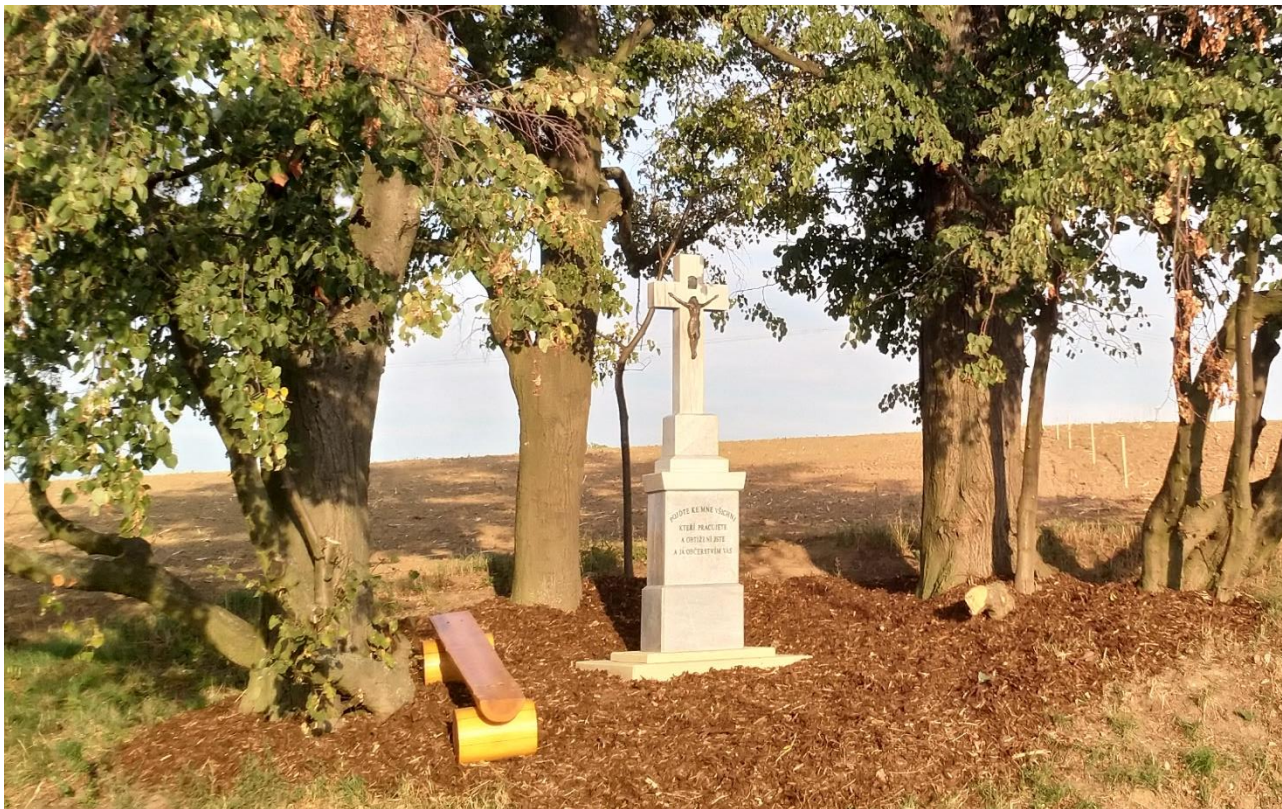
Kříž po opravě a úpravě okolní zeleně
